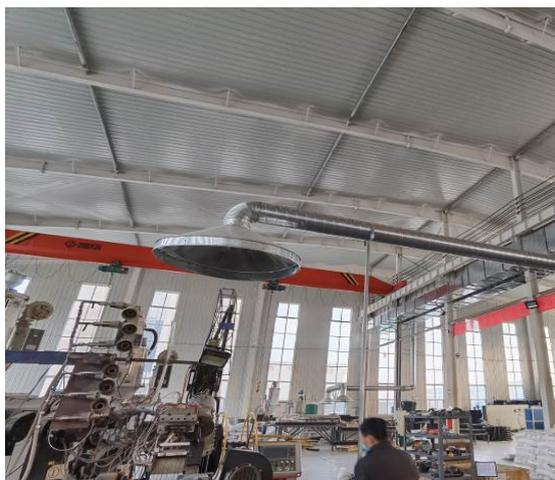
4 号车间生产工序上方设置集气罩
