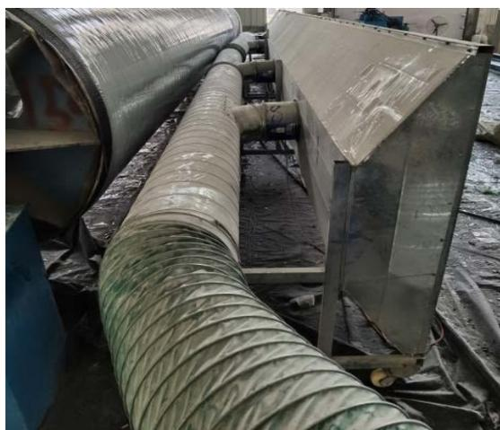
7 号车间缠绕生产线侧方集气罩
