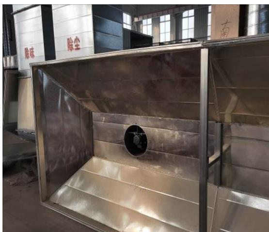
3号车间缠绕工序侧方设置集气罩
